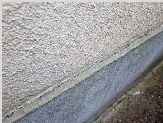
Fotografia 21 i 22 Widoczne uszkodzenia warstw lastryko na cokole budynku.
