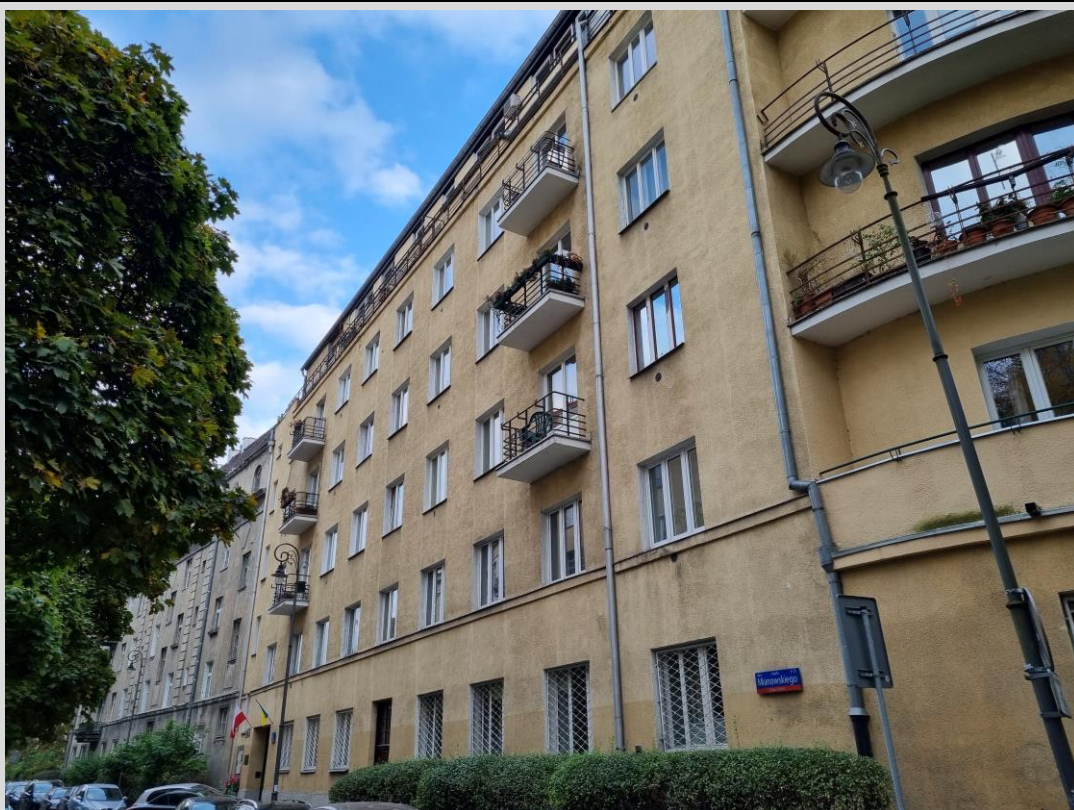
Fotografia 1 Obecny widok elewacji frontowej od strony ul. Mianowskiego.
