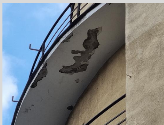
Fotografie 25 i 26 Widoczne zalania i pęknięcia na powierzchni spódów płyt balkonowych.
