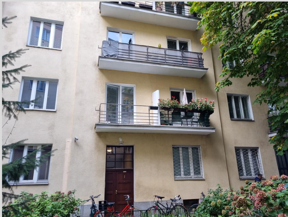
Fotografia 6 Obecny widok elewacji północnej od strony podwórka.
