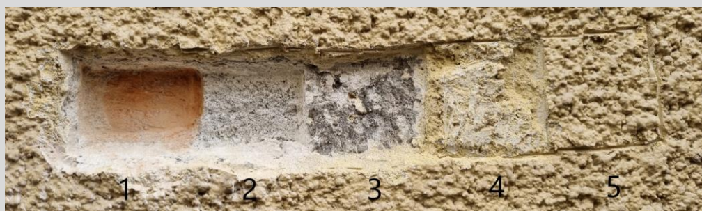
Fotografia 33 Miejsce wykonania odkrywki na fragmencie elewacji frontowej budynku- parter.
