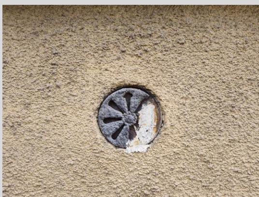
Fotografia 29 i 30 Widoczne skorodowane kratki wentylacyjne.
