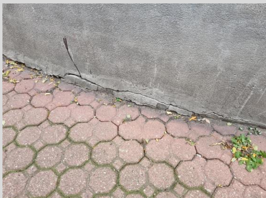
Fotografia 21 i 22 Widoczne uszkodzenia warstw lastryko na cokole budynku.
