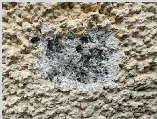
Fotografie dokumentujące wykonanie profilu warstw elewacyjnych na fragmencie elewacji frontowej- V oraz IV piętro
