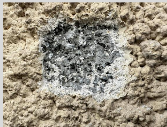
Fotografie dokumentujące wykonanie profilu warstw elewacyjnych na fragmencie elewacji frontowej- V oraz IV piętro
