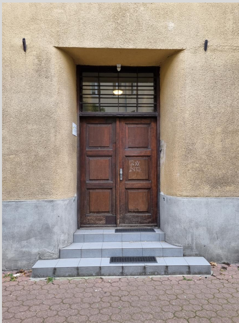
Fotografia 9 Widok wejścia do klatki schodowej na elewacji frontowej.
