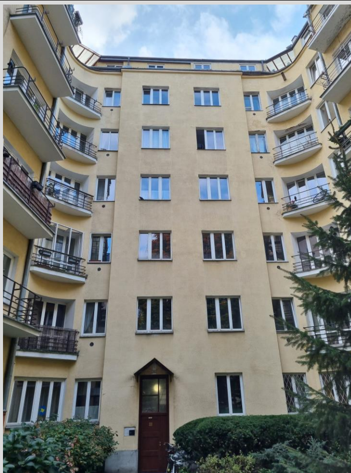
Fotografia 5 Obecny widok elewacji wschodniej od strony podwórka.
