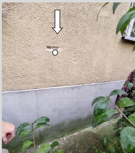
Fotografia 33 Miejsce wykonania odkrywki na fragmencie elewacji frontowej budynku- parter.
