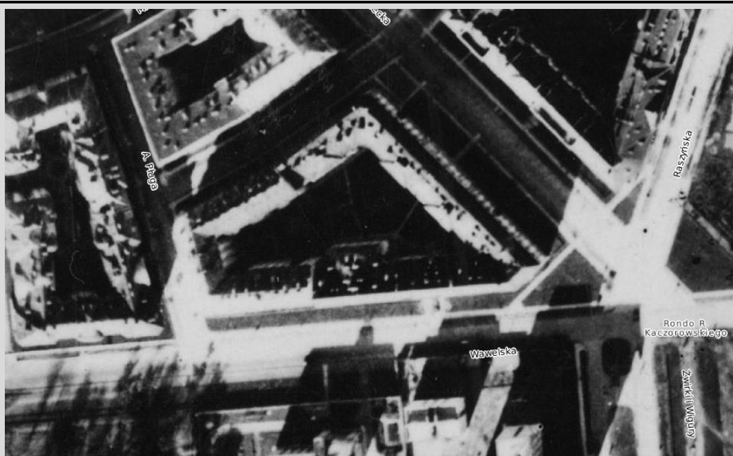
Widok budynku Mianowskiego 15. Zdjęcie wykonano w 1935 roku, źródło: Google Earth.
