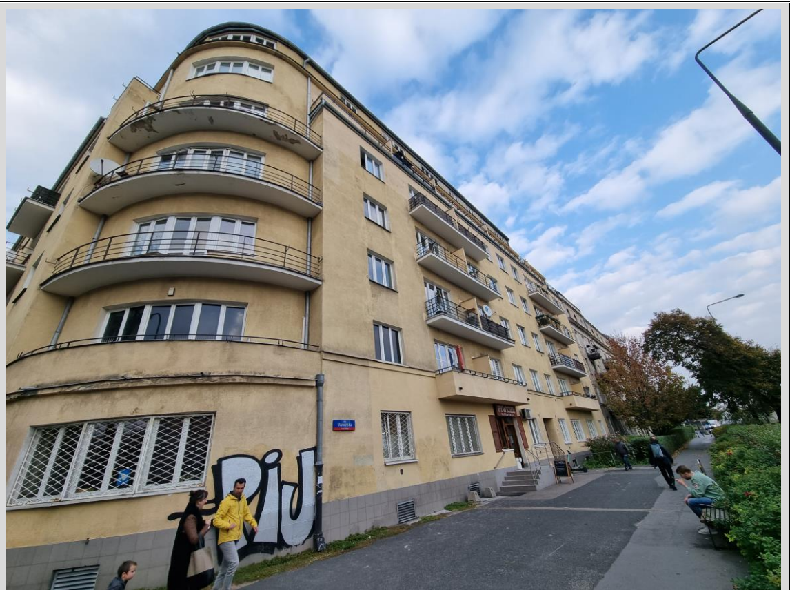
Fotografia 3 Obecny widok elewacji frontowej- od strony ul. Wawelskiej.
