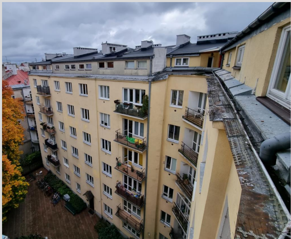
Fotografia 4 Obecny widok elewacji południowej od strony podwórka.
