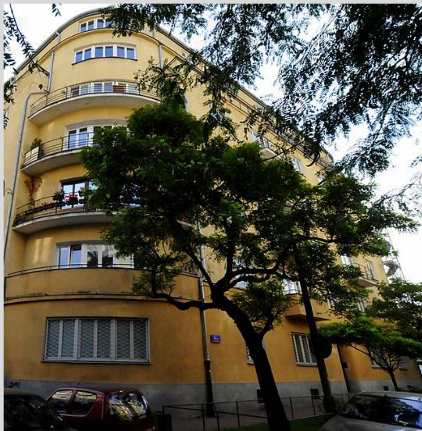
Fotografia 2 Obecny widok elewacji frontowej- od strony ul. Pługa.
